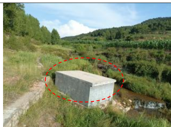
和川镇孔旺集中供水水源地取水口
