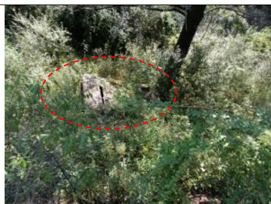
冀氏镇井沟泉集中供水水源地取水口
