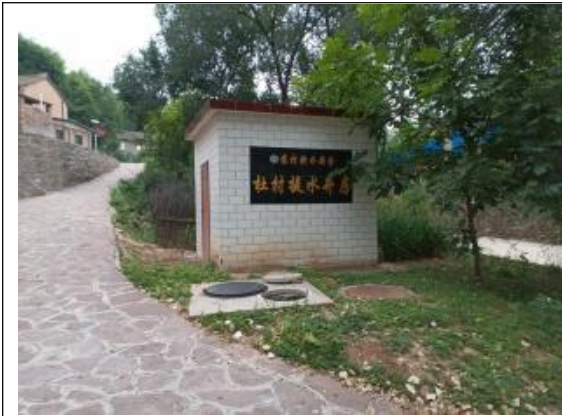
良马镇杜村集中供水水源地取水口
