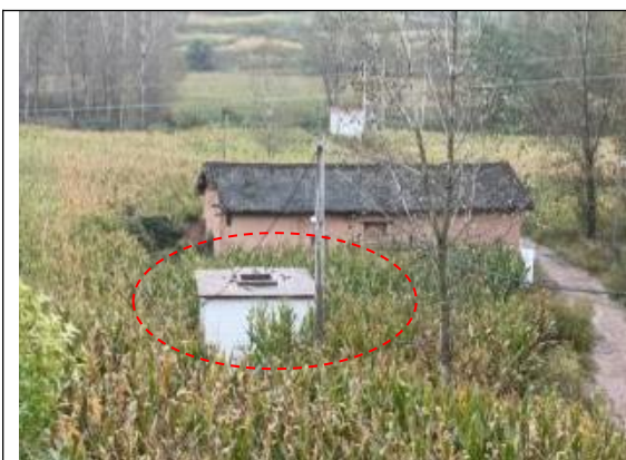
良马镇良马村集中供水水源地取水口
