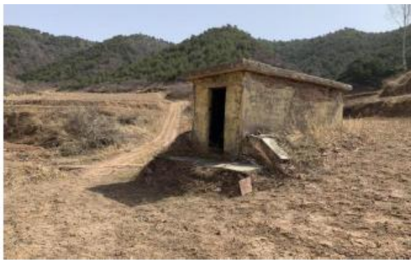
和川镇水井（管道接出，上部封闭）
